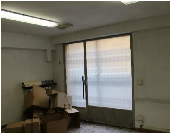
Immagine 3 - Serramento tipo in metallo vetro singolo
