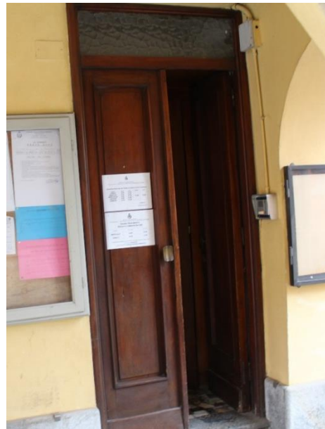
Immagine 4 - Porta di ingresso in legno con sopra luce in vetro singolo
