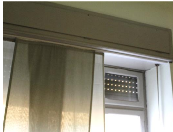
Immagine 6 - Particolare cassonetto non coibentato e tapparella in PVC
