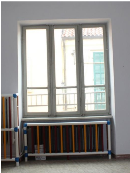
Immagine 5 - Serramenti tipo a tre battenti in legno vetro doppio
